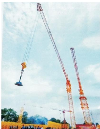
并履行相应审核流程。编制方案框架应以建办质〔2018〕31号文、JGJ215—2010为依据，编制内容应包含工程环境、施工升降机（货用施工升降机）各部位参数及平面定位图、辅助吊装设备选用分析、吊索具选用分析及准备清单、施工进度计划、现场人员（安拆及安全、技术旁站人员）计划清单及职责分工、施工升降机（货用施工升降机）安拆的步骤和方法及各部件吊装工作半径示意图、安全技术保障及应急处置措施、施工现场相应准备工作、检查验收及调试要求（附着应有理论强度计算）。按危大工程划分标准，超过一定规模的，必须组织专家论证。
